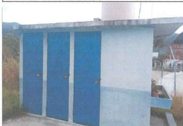
Foto 3: REPARACION DE RED DE DRENAJE
