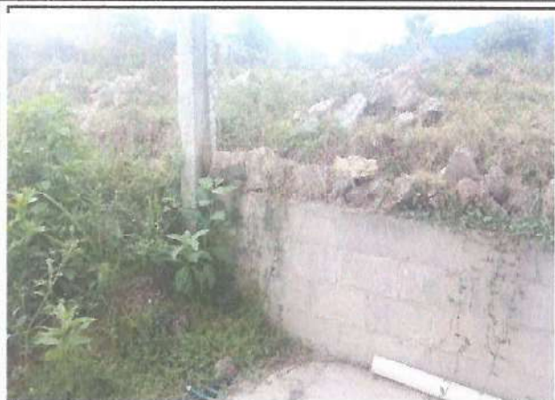
Foto 1: REPARACION DEL MURO PERIMETRAL
