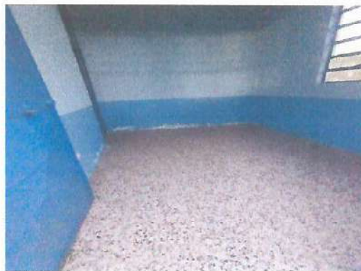
Foto 2: REPARACION DE AREA DE COCINA
